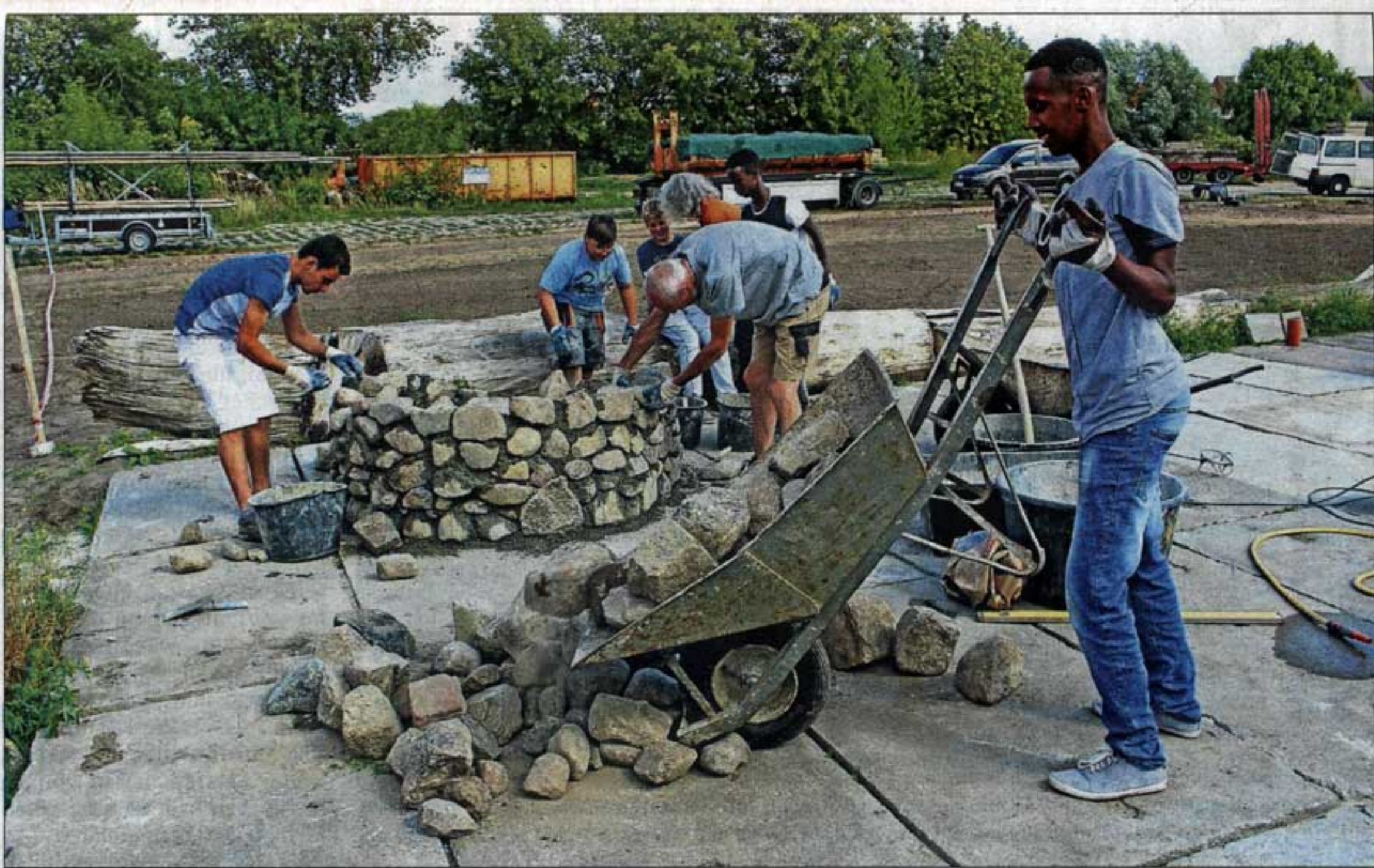
Unter der Anleitung von Markus Grosser aus Tangermünde entsteht auf dem Außengelände des Seehäuser „Refugiums“ ein Lehmbackofen. Minderjährige Flüchtlinge und deutsche Jugendliche unterstützten den Handwerker bei der Arbeit. Fotos (2): Westermann
